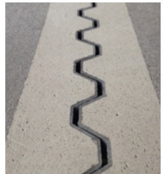
Losa de hormigón después de su reparación
